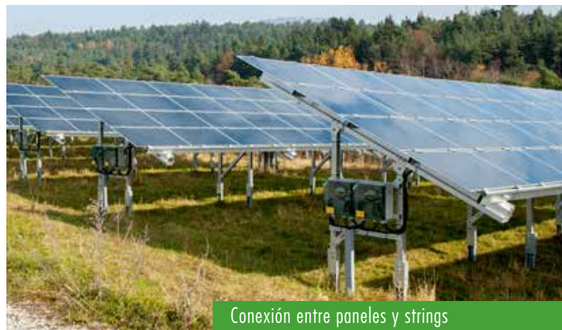
Conexión entre paneles
