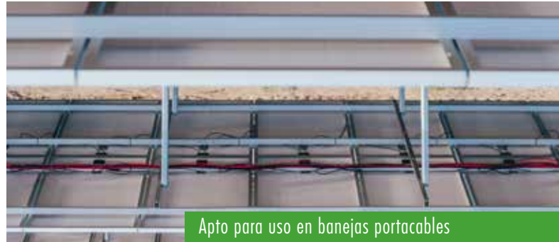
Conexión del panel al inversor
